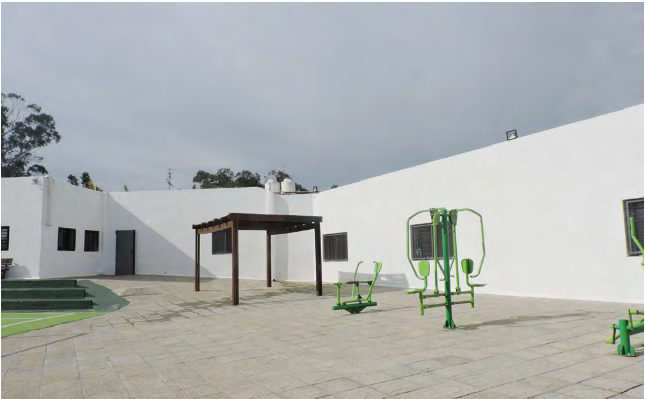
Foto 17. Patio. Centro de atención a episodios agudos.
