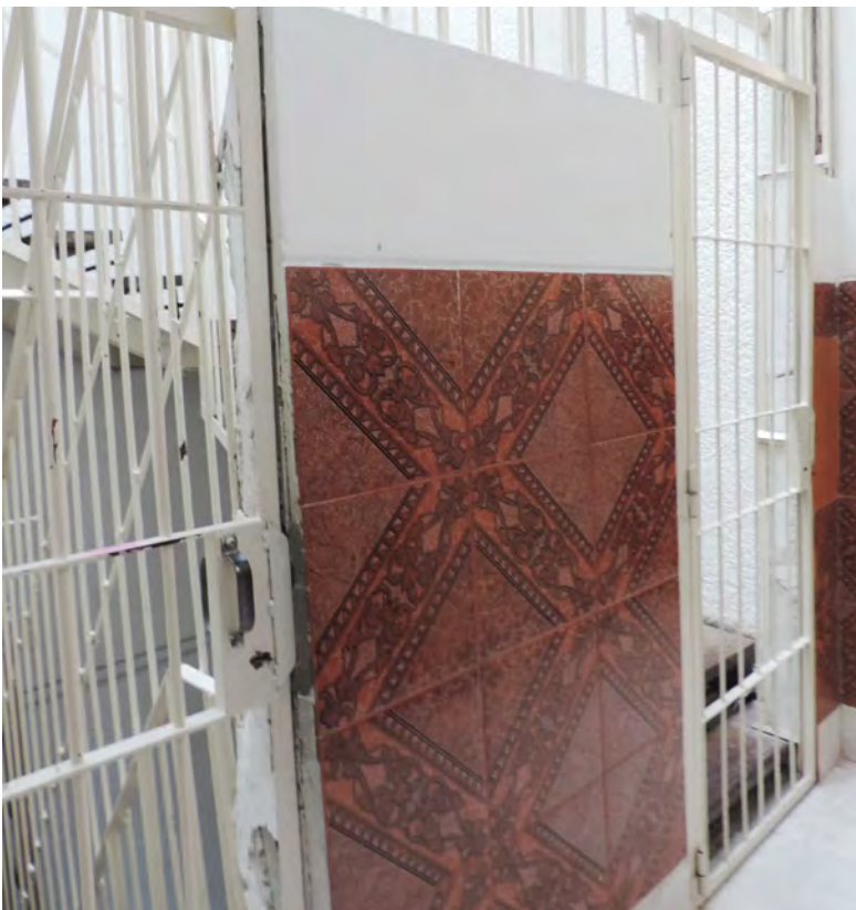
Foto 18. Primer piso, sector varones, puerta de acceso para planta baja y puerta de acceso a segundo piso. Centro de atención en salud mental para adolescentes.
